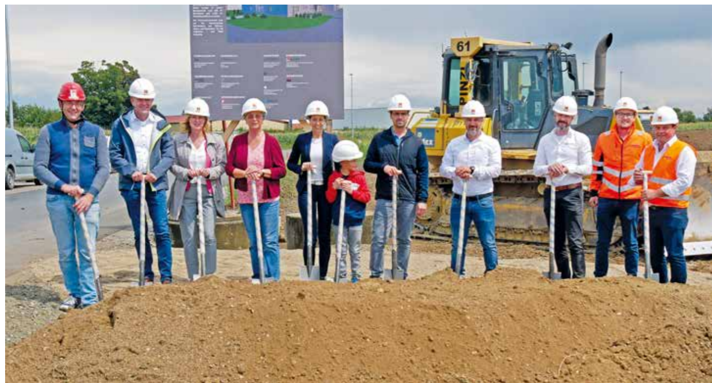
Zum Spatenstich versammelten sich: (v. l.) Johann Anetzberger und Martin Dörfler (beide Fa. Mayerhofer), Martina Dormoolen (VR-Bank), Andrea Holm, Sandra und Florian Holm mit Sohn Jakob, Hans Holm, Tony Ackermann (Projektleiter Fa. Wenger) sowie von der Gemeinde Julbach Geschäftsleiter Bernhard Bründl und Bürgermeister Markus Schusterbauer.
